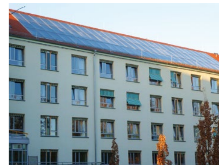
Solaranlage am Kreiskrankenhaus Belzig Die solare Wärme aus dem Kollektorfeld (In-Dach-Montage von 98 Flachkollektoren mit 196 m 2 ) gelangt zunächst in Pufferspeicher (2 x 5 m 3 ) und je nach Bedarf an zwei getrennte WW - Kreise für Trinkwassererwärmung (Speicher: 2 x 8 m 3 ) für Klinikum und Nachheizung der WW-Zirkulation. Der solare Deckungsanteil am WW- Verbrauch (ca. 14 m 3 /Tag bei 60°C) beträgt ca. 43%. Zusatzheizung: Fernwärme, Jahresenergieertrag ca.105 MWh (berechnet), Quelle: H. Rößler
