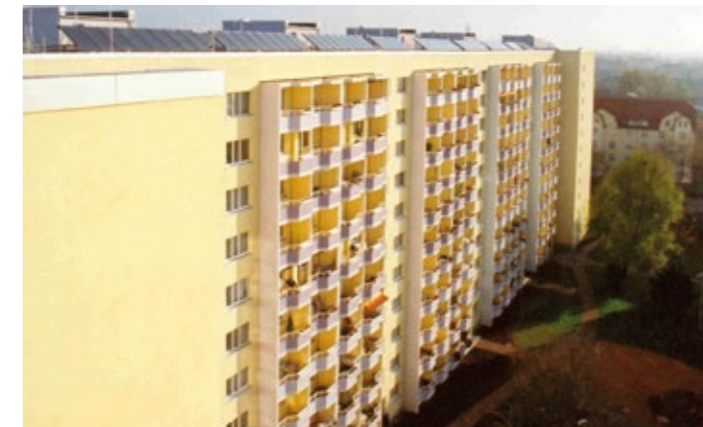
Wohnungsgenossenschaft "Karl-Marx" in Potsdam Das elfstöckige Gebäude ist ein für die 70er-Jahre typischer Plattenbau, der umfassend saniert wurde, einschließlich Erneuerung der gesamten Heiz- und Warmwasserzentrale. Die Trinkwassererwärmung erfolgt durch eine 222 m 2 große Solarwärmeanlage (140 kW th ) und das Nahwärmenetz. Quelle: Wohnungsgenossenschaft "Karl Marx" Potsdam eG
