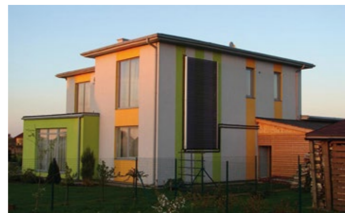
Thermische Solaranlage zur Heiz- u. Brauchwassererwärmung, 6 kWp, 10 m 2 Kollektor mit Vollvakuumröhren, 800 l Pufferspeicher, Kekava (Lettland), Quelle: AkoTec
