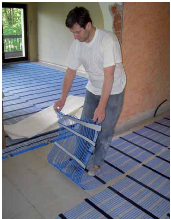
Einbau einer Fußbodenheizung (Kapillarrohrsystem) im Altbau. Die Vorteile der Erdwärmenutzung zeigen sich vor allem in Kombination mit Niedertemperatur-Heizsystemen.
