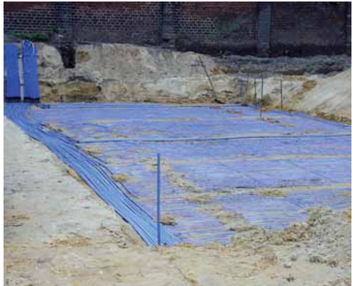
Erdwärme-Kompaktkollektor (Kapillarrohrsystem)
