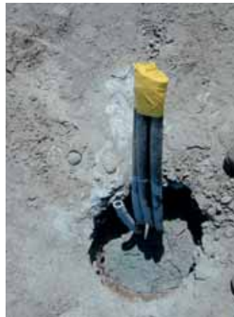
Verfüllte Bohrung mit eingebauter Erdwärmesonde Quelle: Heidelberger Geotechnik, Ennigerloh
