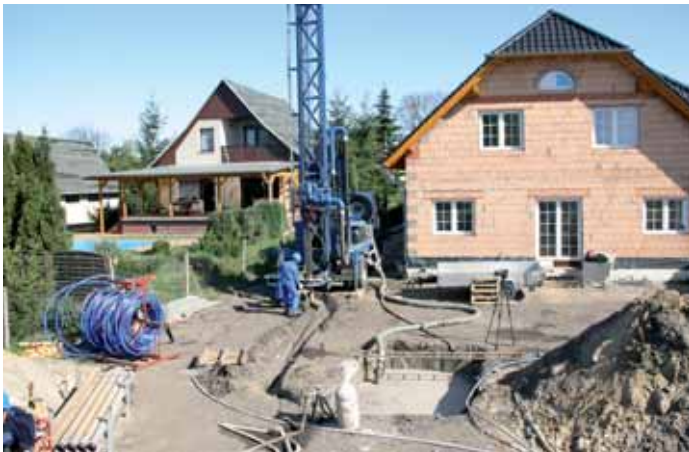
Bohrkran mit Spülungsgrube Quelle: LBGR – N. Schlaak
