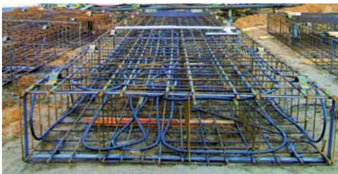
Schlitzwandkorb mit Geothermieleitungen Quelle: Franki Grundbau GmbH & Co. KG
