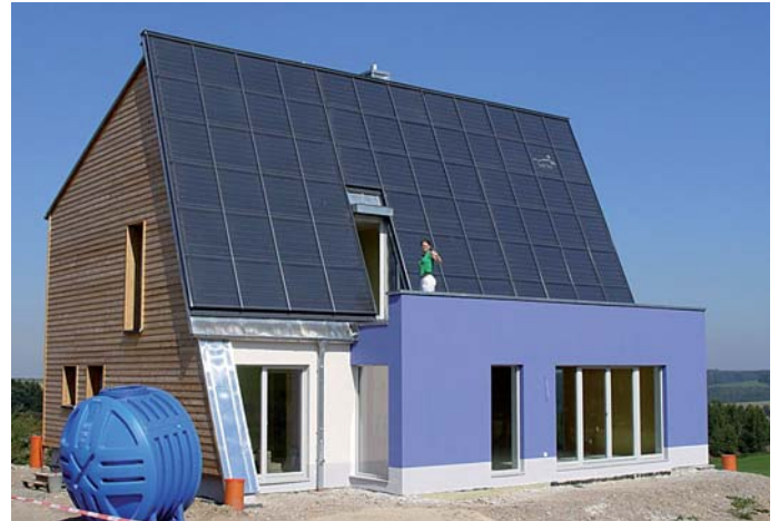
Ganzjahressolarhaus in Berthelsdorf bei Freiberg/Sachsen, 68 m 2 Flachkollektoren, 28.000 l Speicher, 95 % solare Wärmebedarfsdeckung Quelle: Soli fer Solardach GMBH
