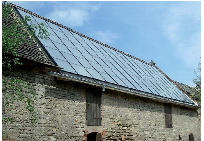
Denkmalgeschütztes Gebäude in Calbe, Mehrfamilienhaus, 96 m 2 Flachkollektoren, 4.000 l Pufferspeicher, Fußboden- und Wandheizung Quelle: RASOLAR
