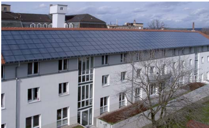
Altenpflegeheim der Caritas in Dresden, 324 m 2 Flachkollektoren, 12.000 l Speicher Quelle: Soli fer Solardach
