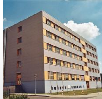
FA Potsdam Einsparung durch Dämmung 200.000 kWh/Jahr
