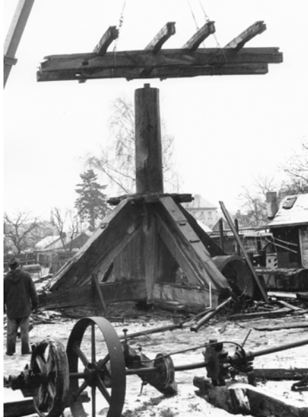
↑ Momentaufnahme des Abbaus in Bohnsdorf: Der Bock steht noch; an der Spitze des Hausbaums, dem zentralen, aufrechten Element, ist oben der Zapfen zu erkennen, der in den Hammer greift. Gerade abgehoben wird der untere Fußboden als letztes drehbares Element. Die Mittelachse des Bodens bilden die zwei Fugbalken. © SDTB, Historisches Archiv
