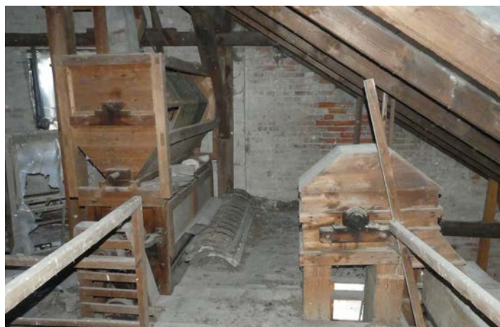
← Verbliebene Reste der Mühltechnik in der Brückmühle
