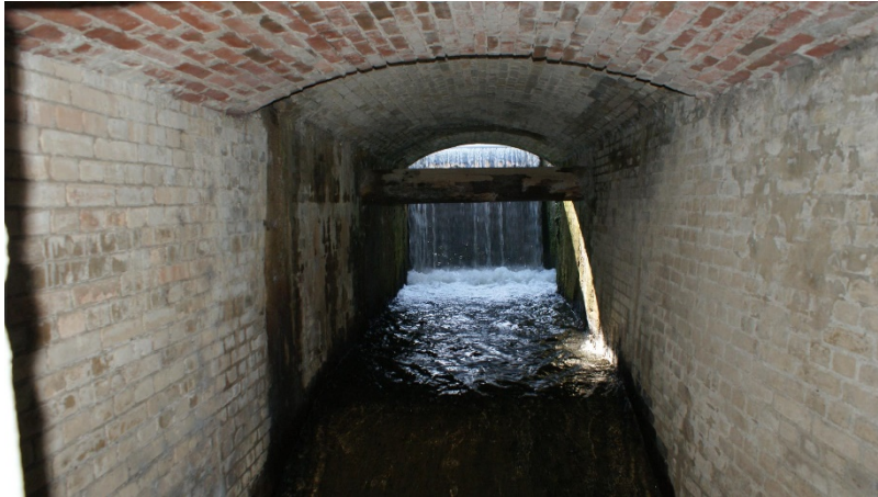
Bild 1: Blick aus Mühlenkeller in die Arche NORD Bauplatz für Wasserrad
