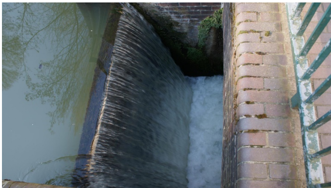
Bild 3: Wassereinlauf am Wehr
